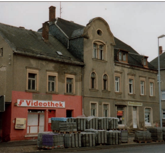
Konditorei und Café Engert/Hösel vor dem Umbau, 1995 jetzt Sanitätshaus Flemig
