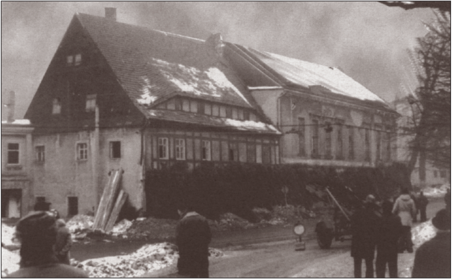
Abb. 6: Gasthof Schönau, Sprengung vorbereitet, Abdeckung mit Fichtenbäumchen, 1979
