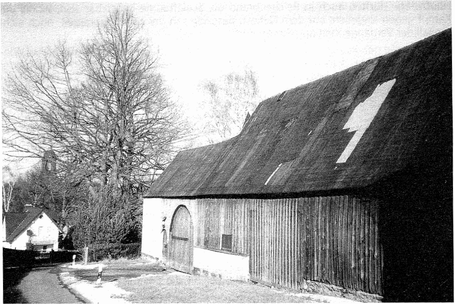
Bild 6: Scheune am Kühnertgut, An den Gütern 8
