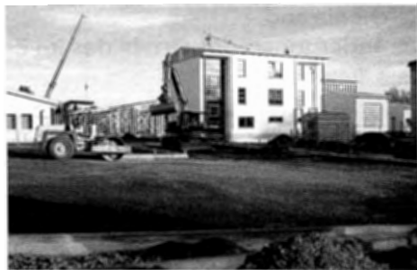
Bild 2: Die Flussmeisterei in der Bauphase, November 2005, Foto: K. Butter
