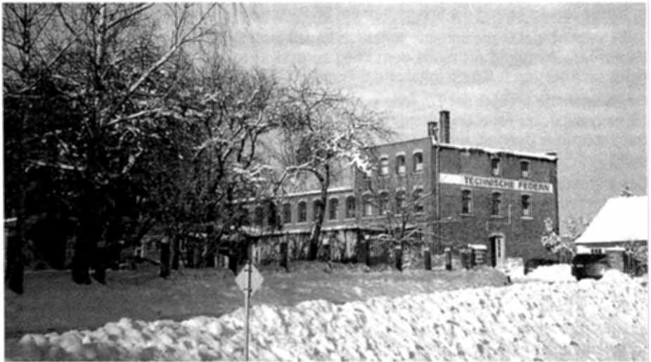
Die Engelhardt´sche Federnfabrik an der Unritzstraße Foto: R. Schwab, 2004
