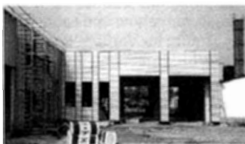
Bau des neuen Autohauses, 1999
