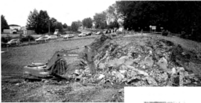
Abbruch der Brücke über die Jagdschänkenstraße, Blickrichtung Chemnitz, 14. August 2002, Foto: K. Butter
