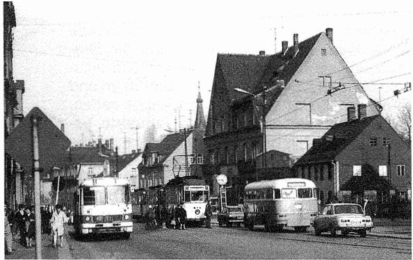
Gefährliche Situation an der Haltestelle Postamt Schönau: Straßenbahn, Fahrgäste und Kraftfahrzeuge teilen sich den Verkehrsraum der Zwickauer Straße.
