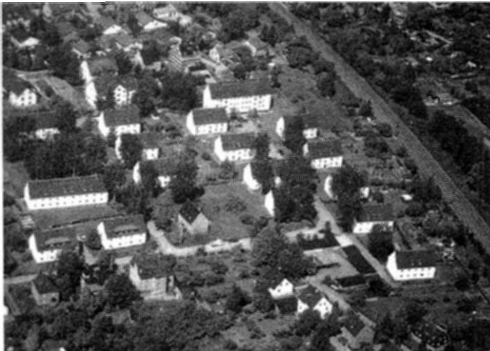
Birkenhof und Baumgartenhof – das sind zwei Siedlungen am westlichen Stadtrand von Chemnitz, etwa 64 Jahre alt, ihr Erscheinungsbild wirkt ansprechend und gepflegt.
