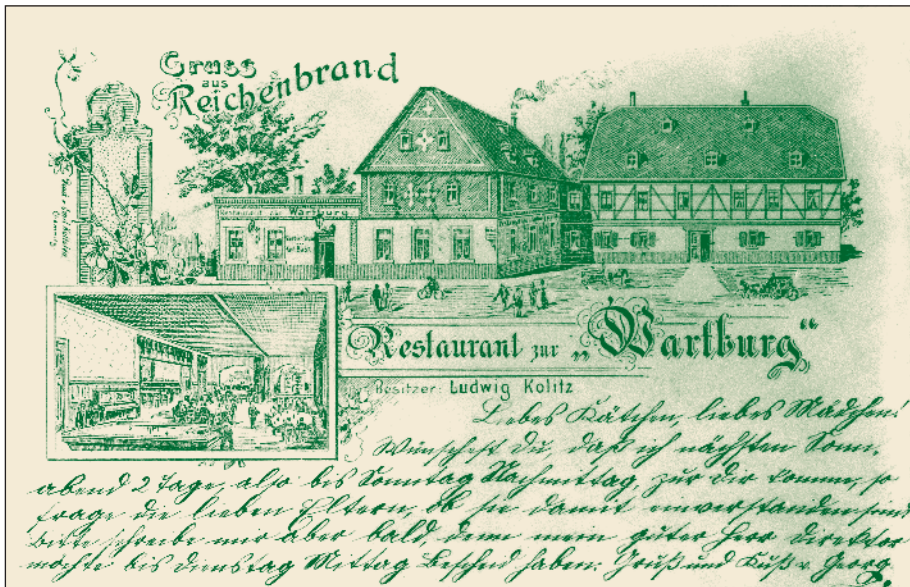
»Gaststätte Wartburg« vor 1870, ehemals Zwickauer Str. 500, vor 1800 erbaut, bis 1946 Gaststätte, später Fotolabor, 1984 Abriss. Die Darstellung zeigt das Anwesen noch mit landwirtschaftlichem Nebenerwerb. Die Aufstockung des linken Anbaus bis zur Firsthöhe erfolgte nach 1871 mit Ziegeln des Schornsteins vom ehem. Hartmannschacht im Auftrag von O. Bergt.
