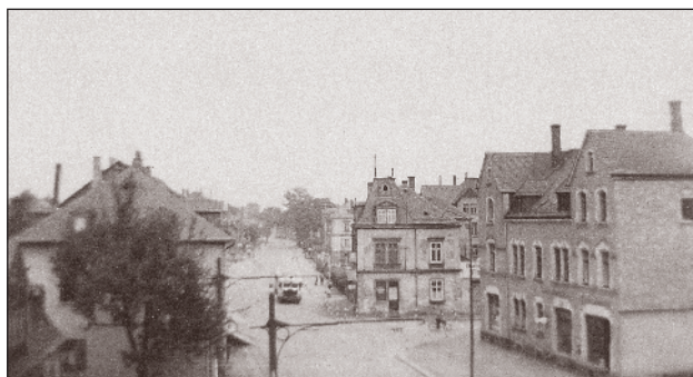
Kreuzung Jagdschänken-/ Zwickauer Straße, fast in Bildmitte steht das erweiterte und aufgestockte ehemalige Zollhaus. Die sichtbare Tür war einst der Eingang zum »Amtsraum«, später zu einer Fleischerei. Zwischen der Apotheke und diesem ehemaligen Haus schaut das
